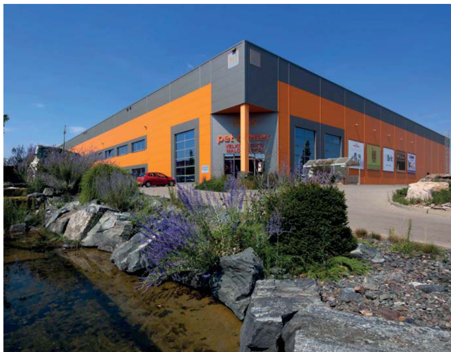
Kombinace skladové a prodejní plochy se v P3 parcích osvědčuje.
