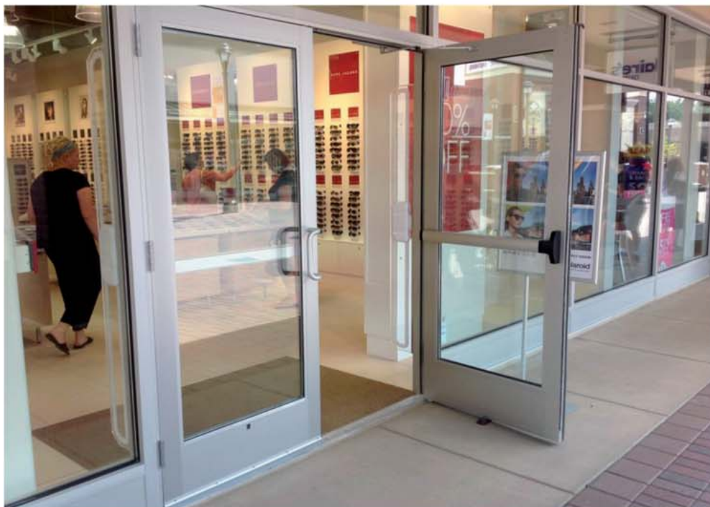
FOTO: INSTALACE ZCELA NOVÉHO AM DOOR SYSTÉMU, FLORIDA, USA
