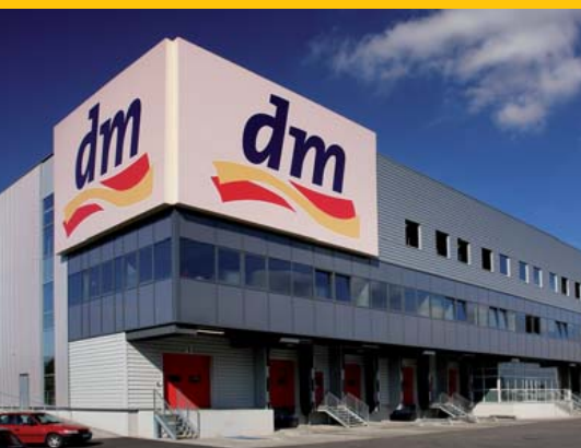
Logistické distribuční centrum dm drogerie markt s.r.o. v Jihlavě.
